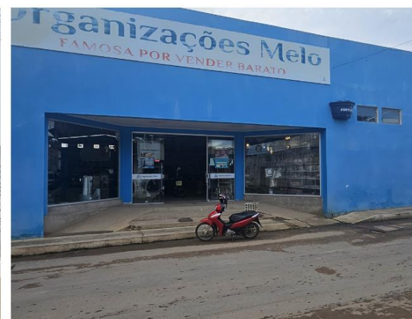
FACHADA DA UNIDADE DML
