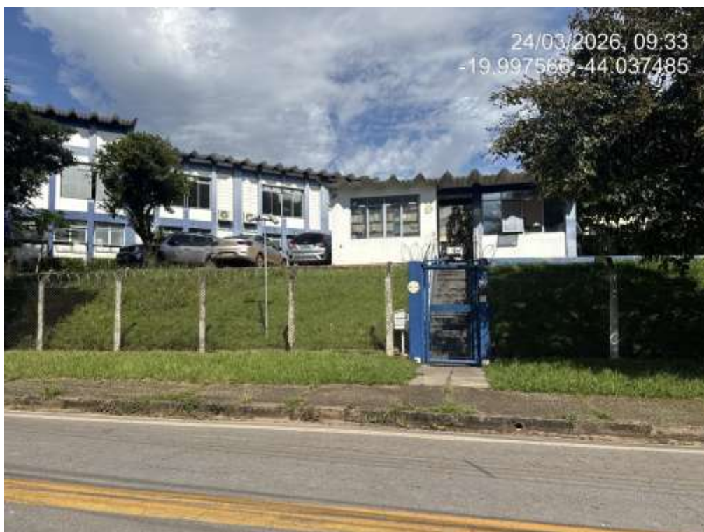
Foto 03: Frente do imóvel – portão de entrada de pedestres
