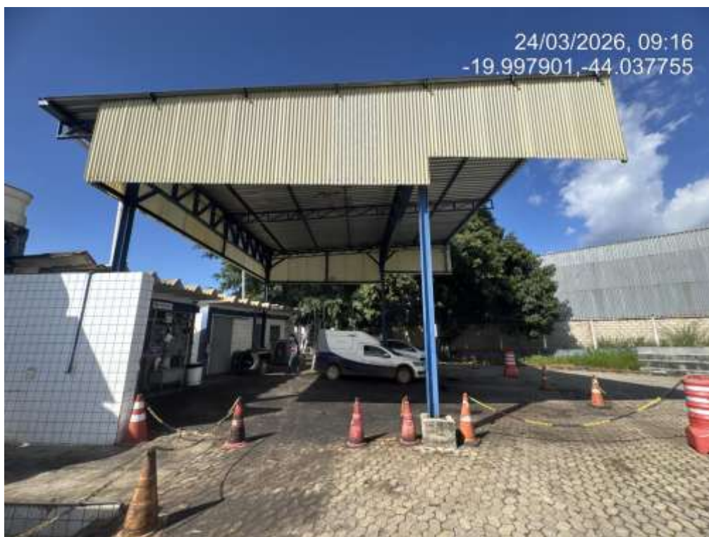
Foto 41: Estrutura mais recente de frente aos prédios auxiliares
