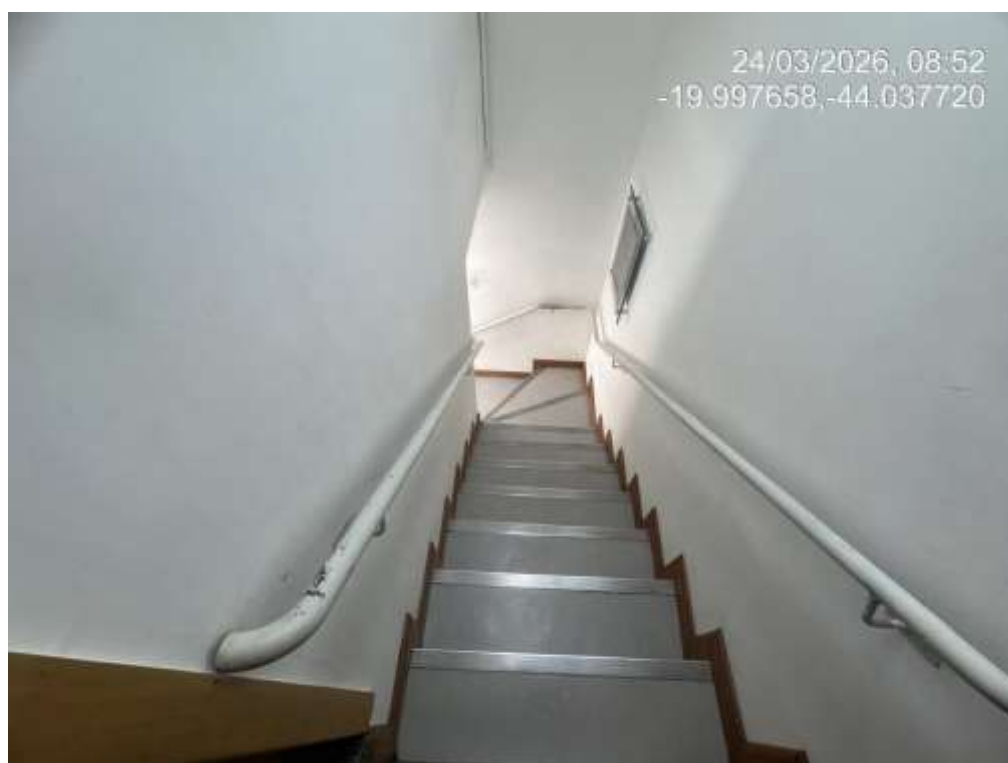
Foto 16: Escada de acesso as salas do piso superior
