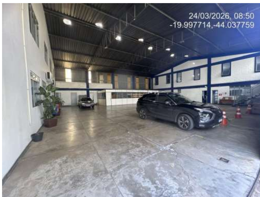
Foto 28: Galpão entre os dois conjuntos de salas
