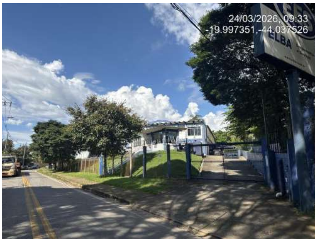
Foto 01: Frente do imóvel – portão de entrada de veículos
