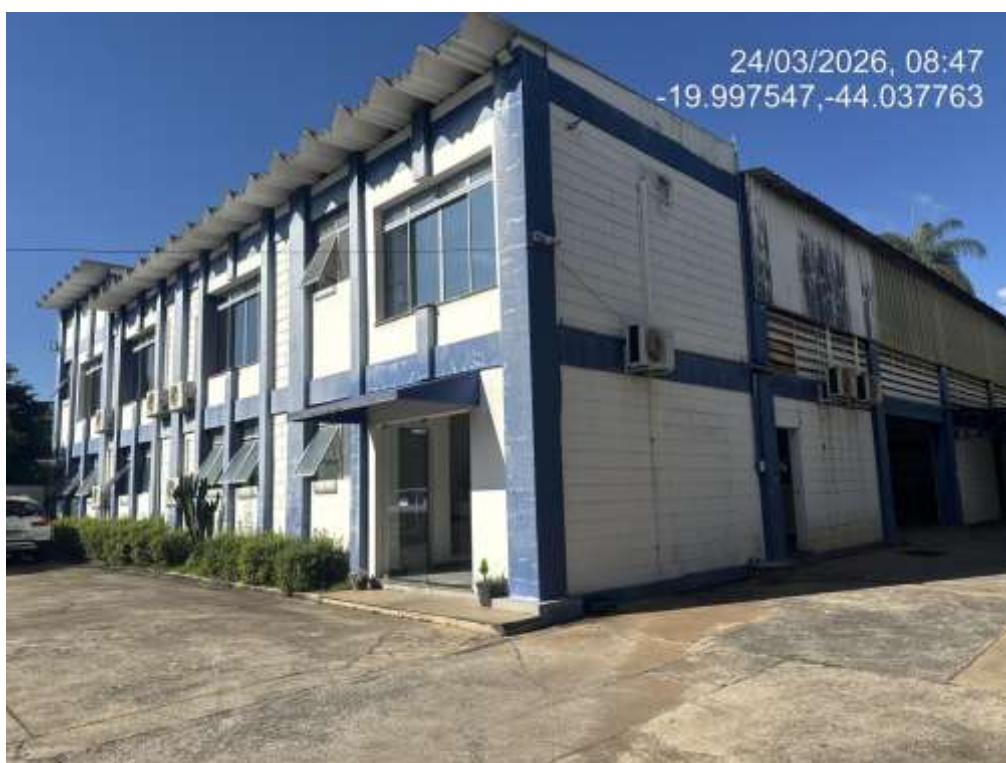
Foto 06: Fachada do prédio principal
