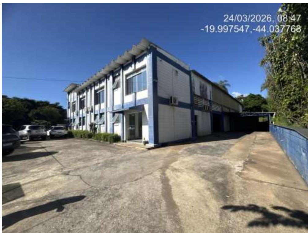
Foto 05: Fachada do prédio principal
