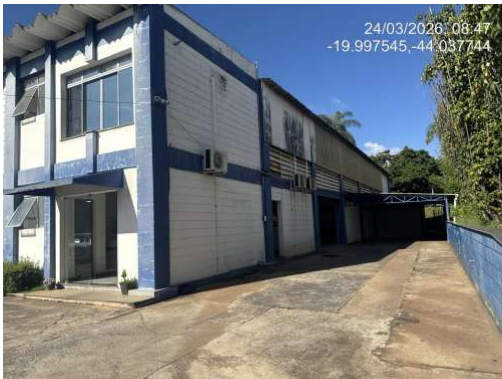
Foto 07: Fachada lateral do prédio principal
