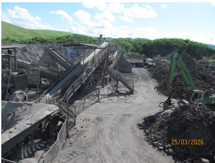
Vista GERAL 2 da PLANTA DE BENEFICIAMENTO DE METÁLICOS – PR-002 (Correias e diversos)
