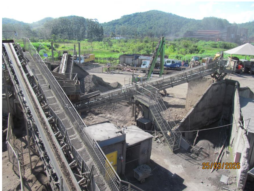
Vista GERAL 1 da PLANTA DE BENEFICIAMENTO DE METÁLICOS – PR-001
