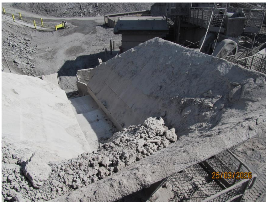
Vista GERAL 3 da PLANTA DE BENEFICIAMENTO DE METÁLICOS – PR-002 (Correias e diversos)
