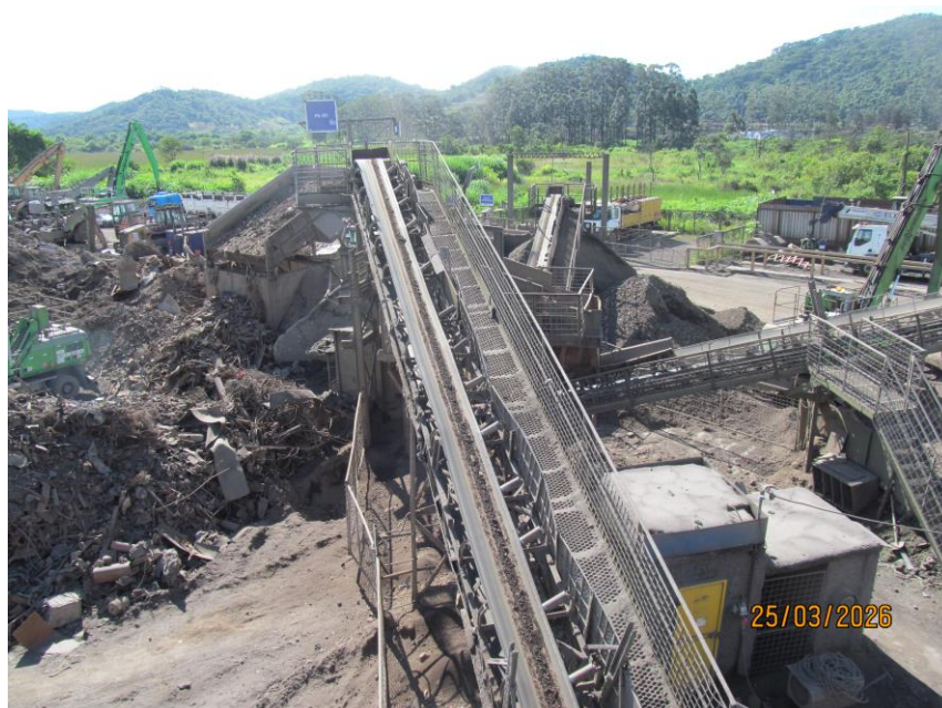
Vista GERAL 3 da PLANTA DE BENEFICIAMENTO DE METÁLICOS – PR-001
